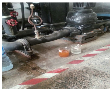
图 3 系统中放出乙二醇与干净乙二醇对照图
