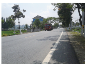
图 10 泡沫沥青作稳定剂二次冷再生路面(一年后)
