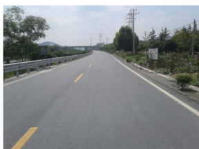
图 11 水泥作稳定剂二次冷再生路面(一年后)
