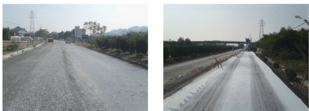
图 9 水泥作稳定剂二次冷再生试验路
