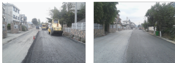
图8 泡沫沥青作稳定剂二次冷再生试验路
