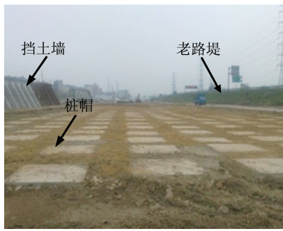
图 1 试验段地基加固现场
